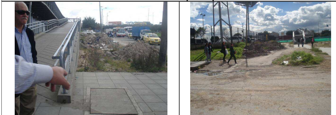
Escombros en el espacios público costado oriental Avenida Boyacá Proyecto 317
